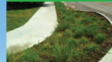
**Zanjas**, que son canales poco profundos con lados inclinados, se instalaron a lo largo de la calle 24. Zanjas imitan los flujos de agua naturales para gestionar con mayor eficacia escorrentías des de agua para que se infiltre en lugar de entrar en el sistema de alcantarillado combinado. Como parte del Proyecto de separación de alcantarillas de las calles 26 y Corby, estas zanjas son funcionales y atractivas.
