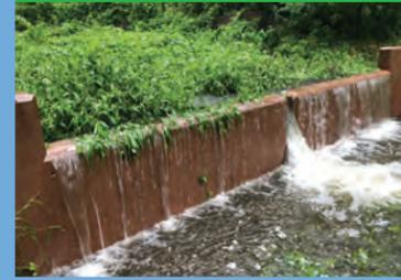
Elmwood Park proporcionó una excelente ubicación para estructuras llamadas **vertederos ranurados**, que fueron construidos a través del barranco del parque para reducir la velocidad de las aguas pluviales y la erosión. Los vertederos actúan como terrazas, con jardines de retención de escurrimiento situados entre las caídas verticales, para frenar las aguas pluviales. Se sembraron pastos autóctonos en los jardines para proveer la superior absorción de agua natural.
